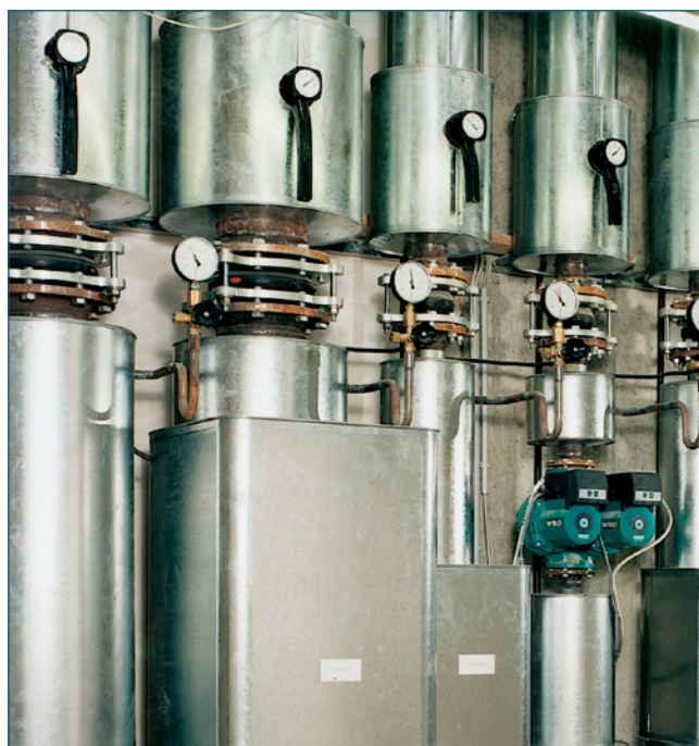
Příklad montáže klapky Z011-A therm s vloženým teploměrem
