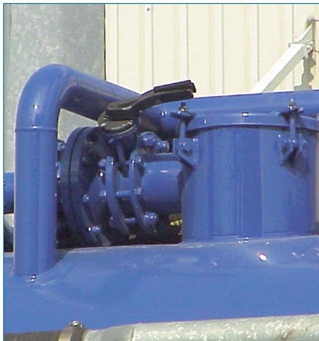
Příklad montáže kontejnerové klapky TW 150
